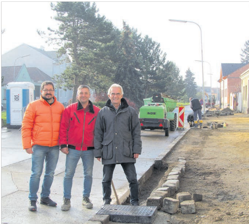
Machten sich vor Ort ein Bild vom Voranschreiten der Arbeiten: Amtsleiter Hannes Laschober, Polier Franz Halper und Bürgermeister Ernst Schüller.
